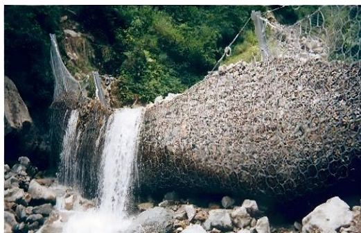
图 1 泥石流柔性防护网拦截泥石流
