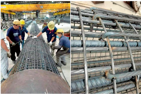
(b) #5刚棒锚固加工实物图
