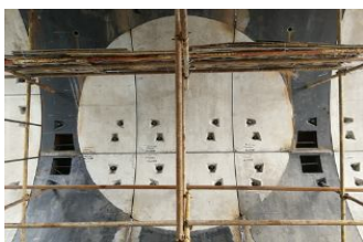
图 2 机械法联络通道洞门
