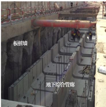
图 1 地下综合管廊施工图
