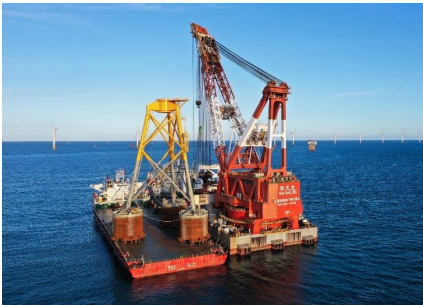
图 1 吸力筒导管架基础
