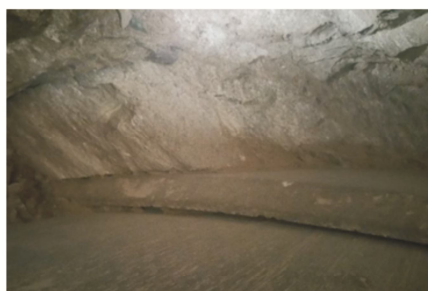
(d) T14+080—T14+100段TBM卡机情况
