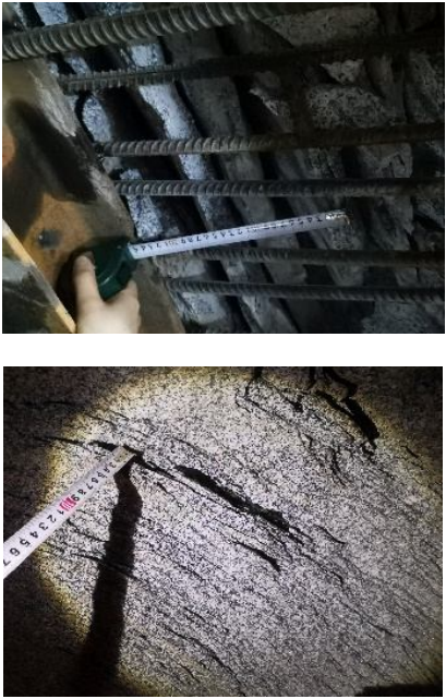
图 7 围岩板裂破坏
