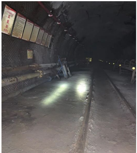
图 20 复合岩巷返修效果图 Fig. 20 Repair effects of composite rock roadway -830 水平大巷复合岩巷区段返修支护实际效果
