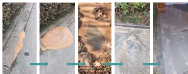
图 16 某盾构隧道冒浆过程
