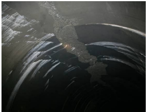
图4 汶川地震龙溪隧道开裂
