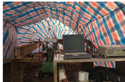
(b) #2试桩荷载试验照片
