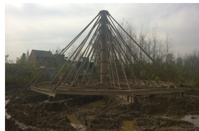
(a) #1试桩荷载试验照片
