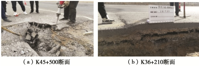
图 4 公路 B (国道) 试坑开挖情况
