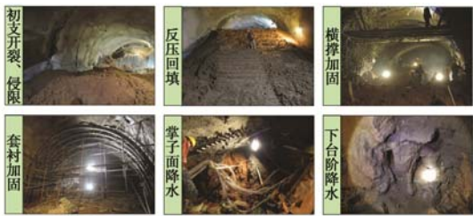
图 2 隧道围岩失稳破坏及相应施工措施
