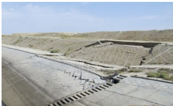
图 1 典型膨胀土渠道滑坡
