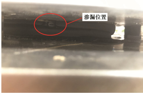
图 9 “T 字缝”角部渗漏
