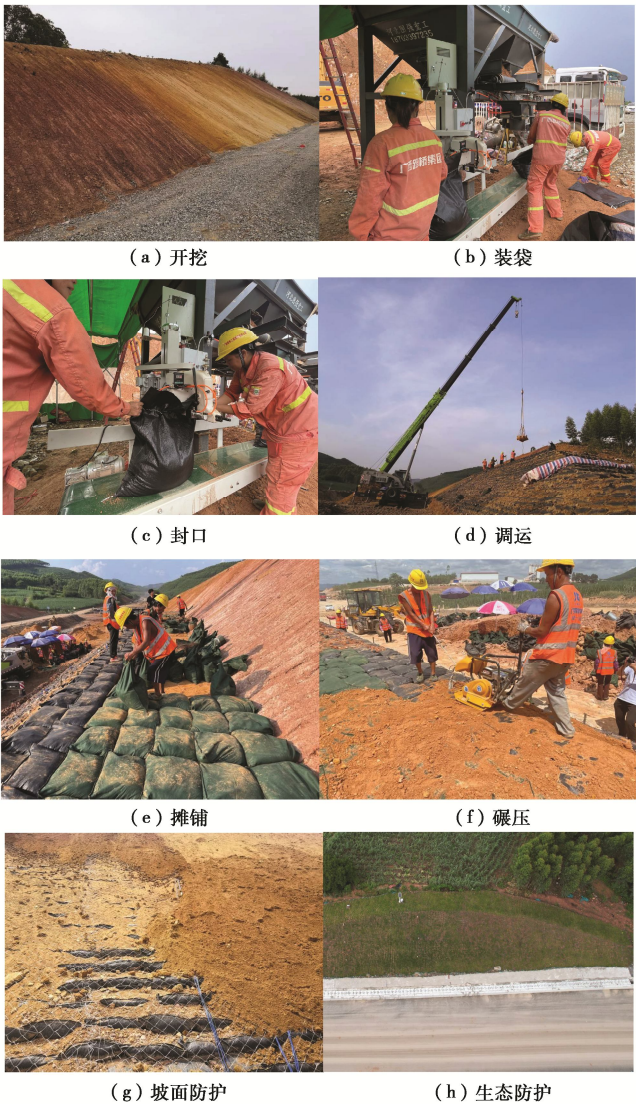
图 7 土工编织袋防护膨胀土路堑边坡现场施工
