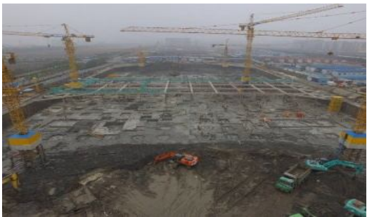
图 4 新型桩-土-撑体系基坑支护现场图
