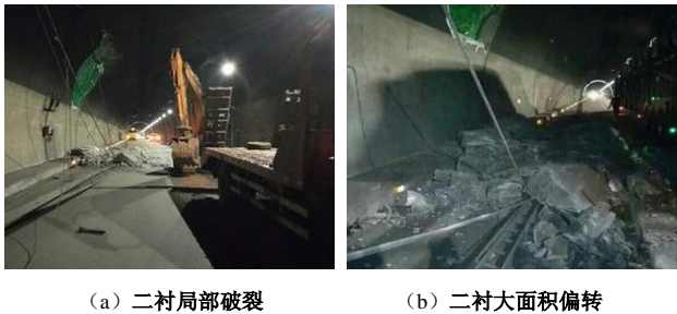
图 4 二衬破裂及偏转现场
