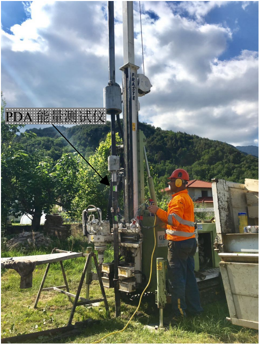
图 6 意大利 Avasinis 动力触探及锤击能量测试 Fig. 6 DPT and hammer energy measurement at Avasinis in Italy
