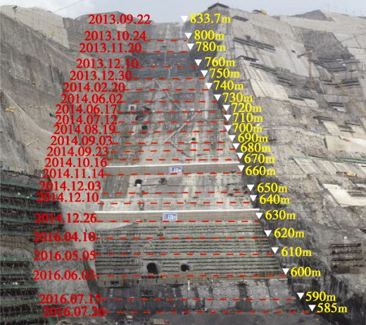
图 3 左岸坝肩边坡分层开挖进度
