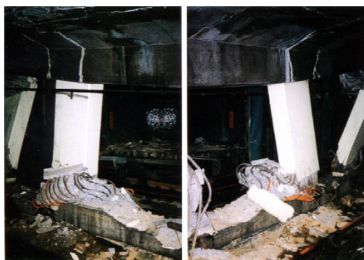
图4 大开车站中柱破坏图
