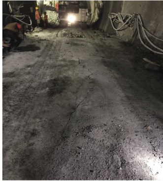
图 10 PDK50+468 断面附近仰拱开裂隆起
