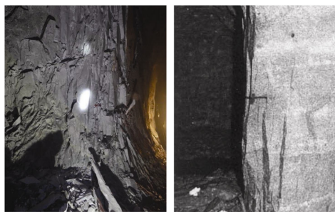
图1 隧洞边墙板裂破坏现象 [8-9]
