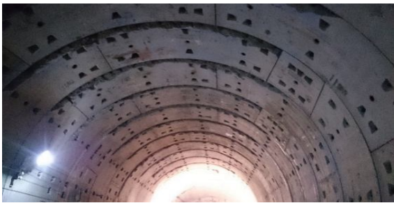
图 12 环向区域性剥落
