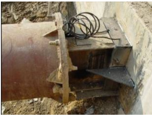
图 2 轴力计安装实例示意图
