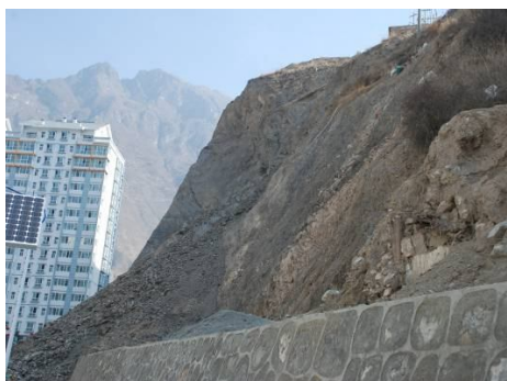
图 1 FG 区边坡加固前坡面
