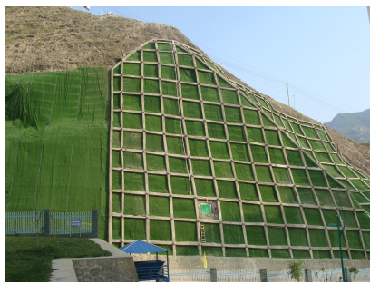
图 2 FG 区边坡加固后现状
