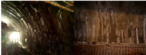
图 13 初支渗漏水现场照片 Fig. 13 Photos of seepage in tunnel
