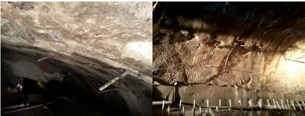
图 15 初支渗漏水注浆治理后现场照片 Fig. 15 Photos of tunnel after grouting
