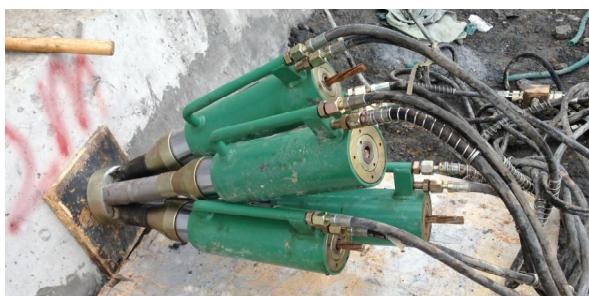
图 3 多个千斤顶对各锚筋同步张拉
