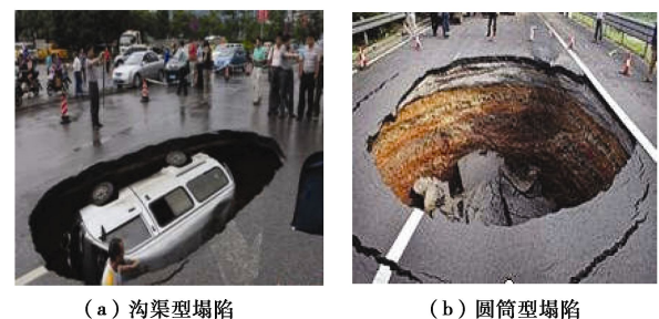
图4 土洞塌陷的地表形态
