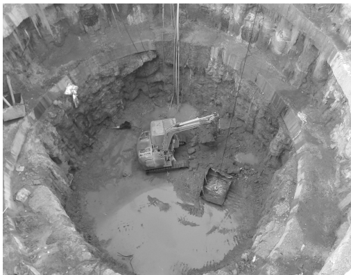
图 10 抗浮锚杆-旋喷体封底无降水深基坑
