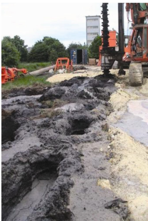
图 3 SMiRT 项目中使用的三螺旋钻系统 Fig. 3 Auger used in SMiRTfield trials
