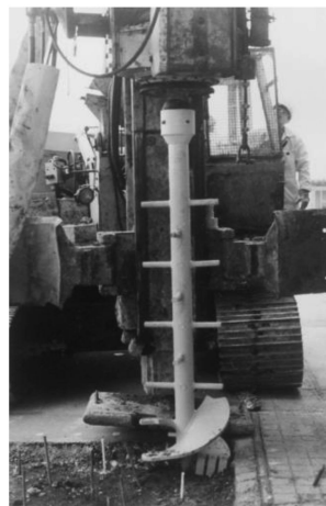
图 1 West Drayton 项目中使用的单螺旋钻 [15]
