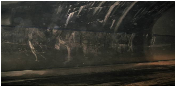
图 6 衬砌网状开裂、渗水
