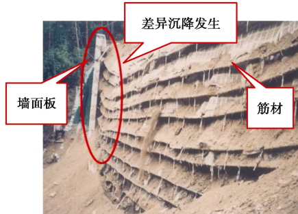
图1 加筋土挡墙实际变形破坏图示
