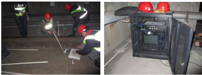
图 2 传感器及解调仪现场安装图
