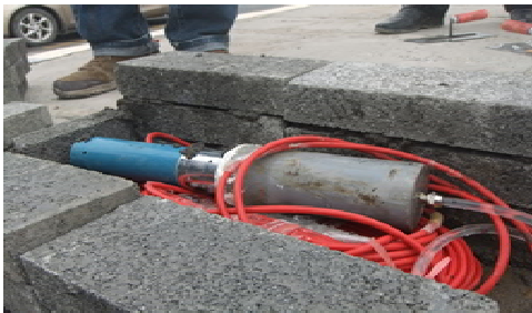
图 6 基准传感器的埋置与保护
