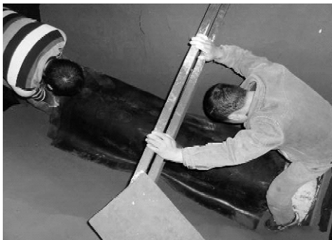
图 3 海绵橡胶板模拟减震层
