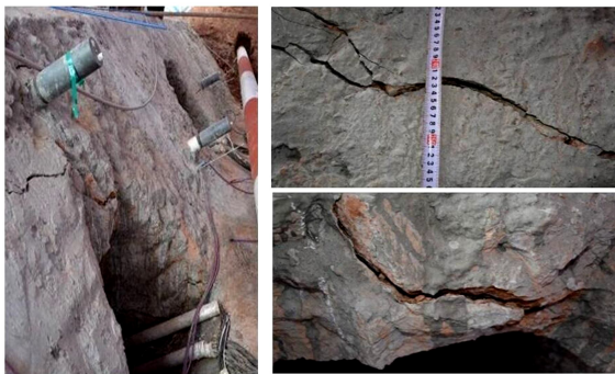
图 13 软岩隧道锚围岩破坏裂缝
