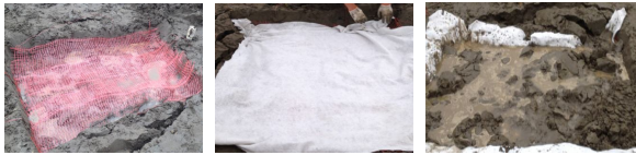
(a) 埋设土工格栅 (b) 铺设土工布 (c) 砂土回填
