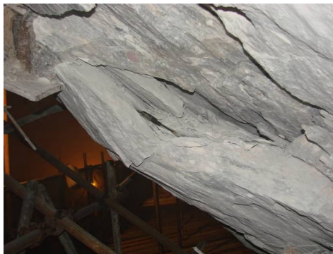
图 9 锦屏地下厂房下游拱腰围岩变形破坏照片
