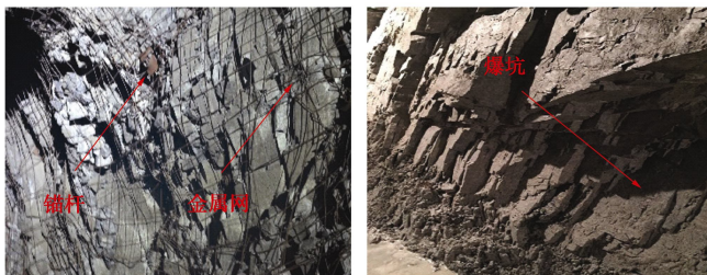
图1 马路坪矿640中段板裂化破坏与岩爆现象
