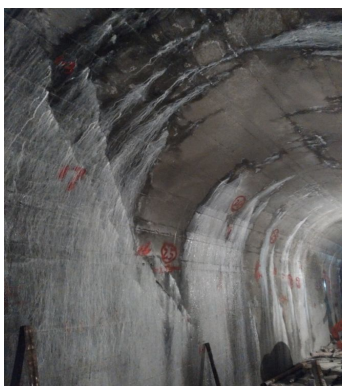
图 3 廊道裂缝情况
