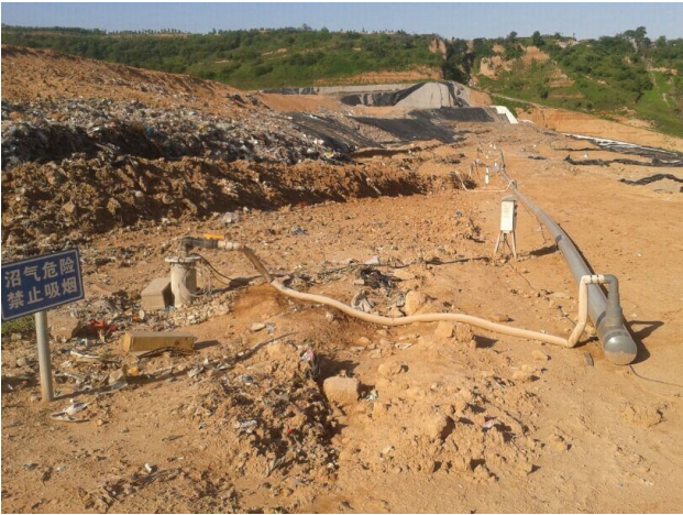
图 3 排水竖井现场布置图 Fig. 3 Layout of drainage wells
