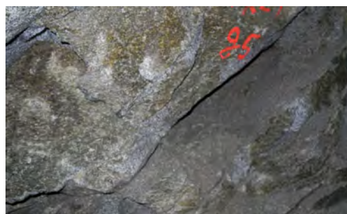
图11 PD05 洞深 0+98 m 上游壁发育破碎带(含岩屑)
