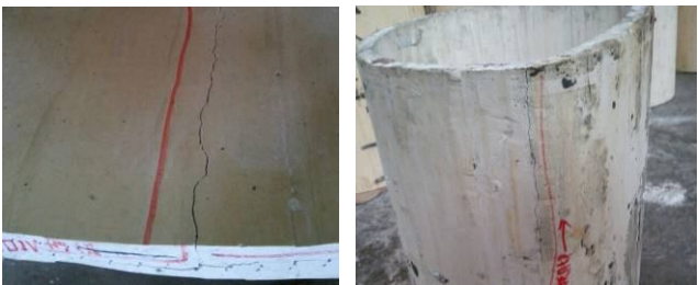
(a) 第 1 条裂缝(仰拱) (b) 第 3 条裂缝(左墙脚)
