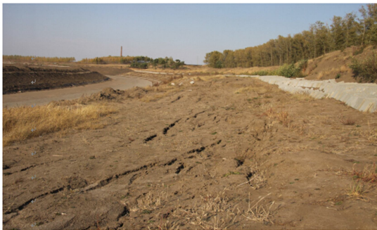
图 1 滑坡破坏情况 Fig. 1 Landslide destruction
