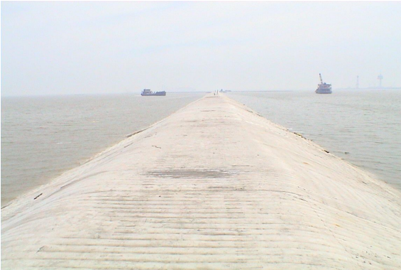
图 3 完工的固化土海上围堤
