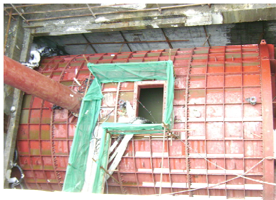
图 12 龙华站辅助盾构接收钢套筒结构
