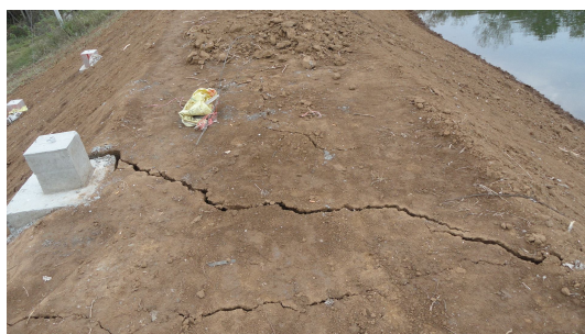
图 14 坝顶贯穿性裂缝图
