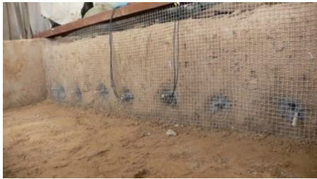
图 5 第一次施工循环中的坑壁
