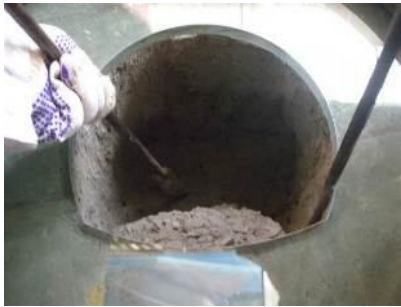
图 10 人工开挖 Fig. 10 Manual excavation
